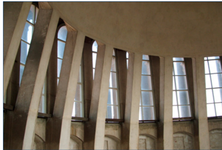
Vista del sistema di pilastri in mattone del giro più interno L'immagine è presa all'interno della cupola, sopra la tazza cassettonata; notare la straordinaria essenzialità del linguaggio strutturale: non esistono più né capitelli, né cornici; tutto è fluido come fosse un elemento naturale
