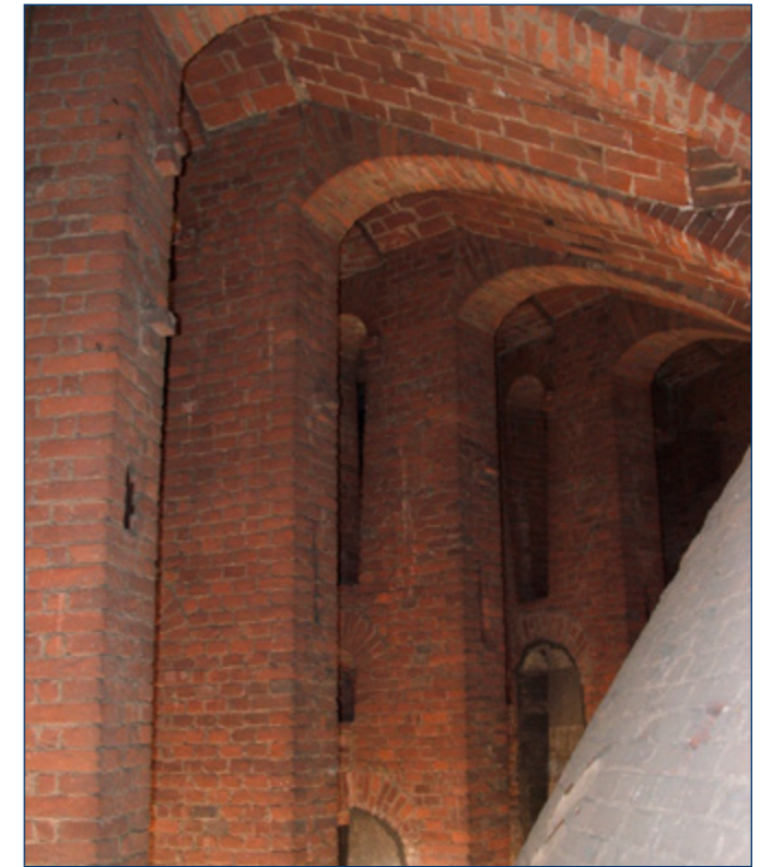
Vista del sistema di pilastri del giro più interno L'immagine è presa all'esterno, all'altezza della tazza cassettonata che è controventata ai pilastri da un sistema di archi rampanti
