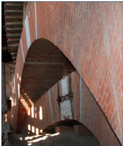
Coppia di arconi di imposta della cupola, lato Ovest (sottotetto della navata centrale) Notare la straordinaria cura ed uniformità di apparecchio laterizio, con i mattoni piallati a cuneo per ridurre il giunto di malta di calce
